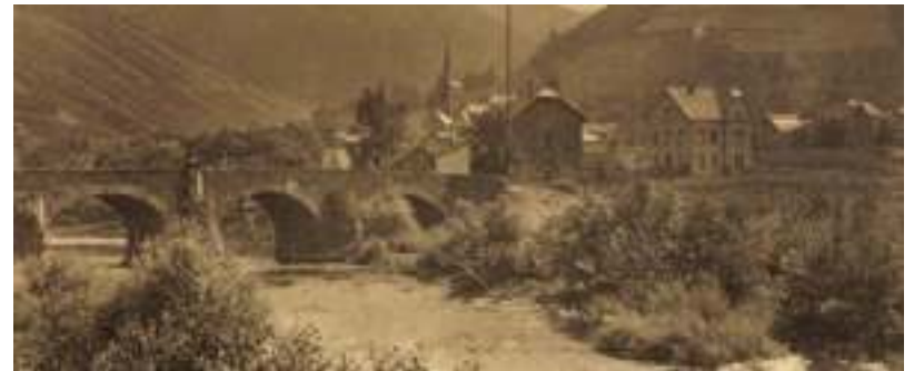
Auswahl historischer Postkarten, die eine Verlandungstendenz am rechten Ufer und zu geringen HW-Schutz des rechten Widerlagers zeigen
