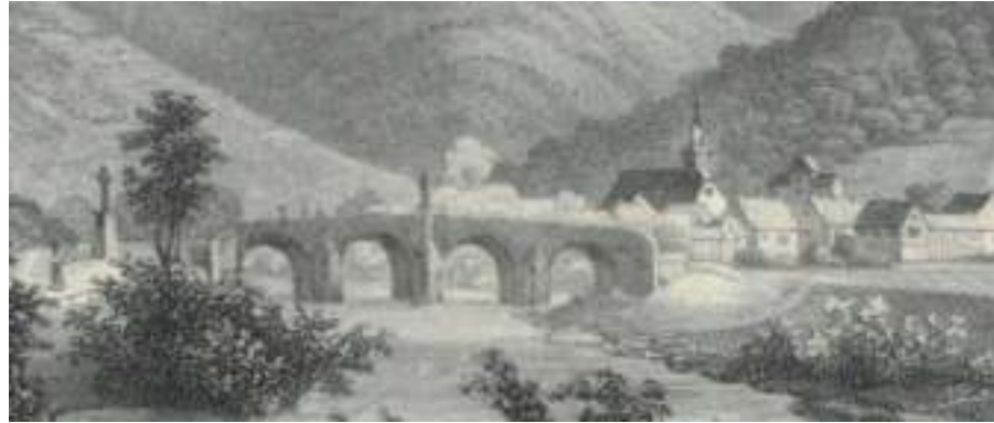
Auswahl historischer Postkarten, die eine Verlandungstendenz am rechten Ufer und zu geringen HW-Schutz des rechten Widerlagers zeigen
