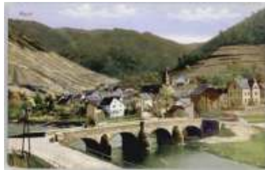
Auswahl historischer Postkarten, die eine Verlandungstendenz am rechten Ufer und zu geringen HW-Schutz des rechten Widerlagers zeigen
