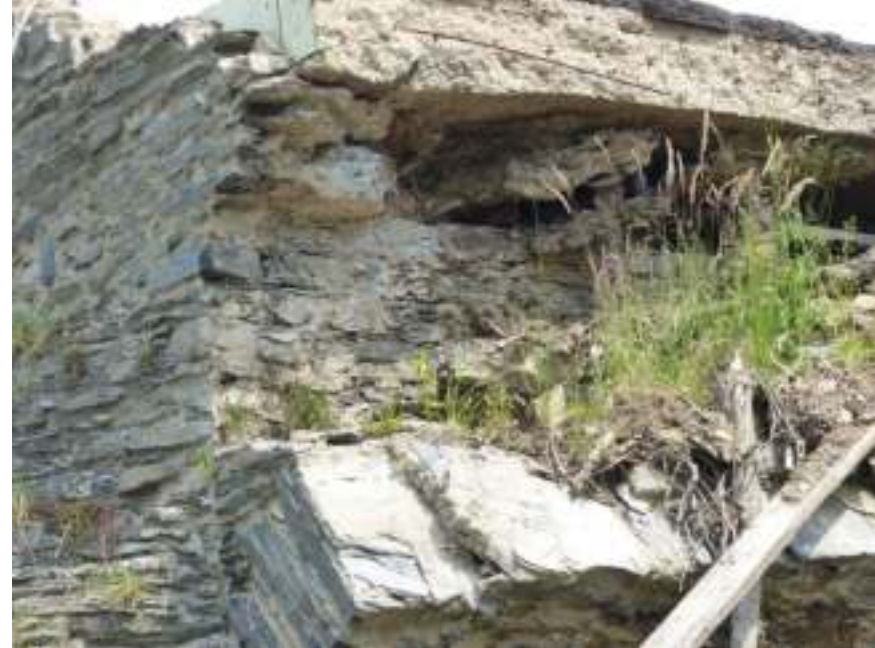
Vollausmauerung im Zwickel 1804 und früher, extrem dauerhaft
