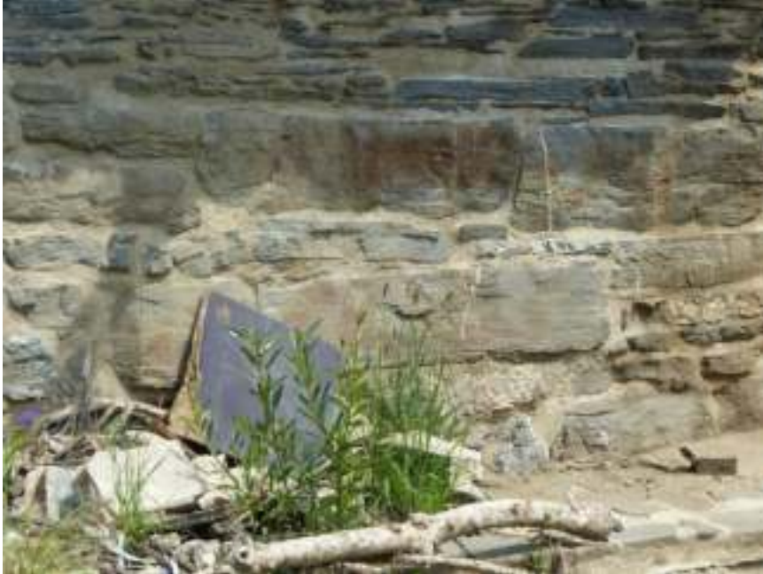
Vollverfugung Außenmauerwerk, maschinell 2008, extrem dauerhaft
