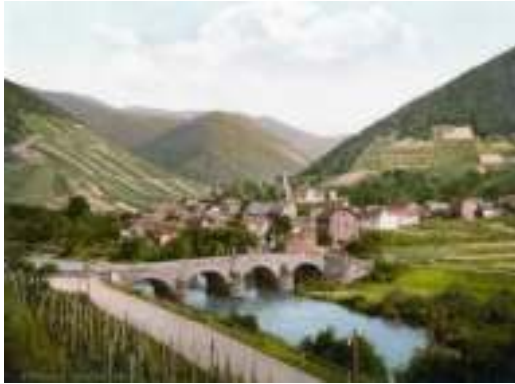
Auswahl historischer Postkarten, die eine Verlandungstendenz am rechten Ufer und zu geringen HW-Schutz des rechten Widerlagers zeigen
