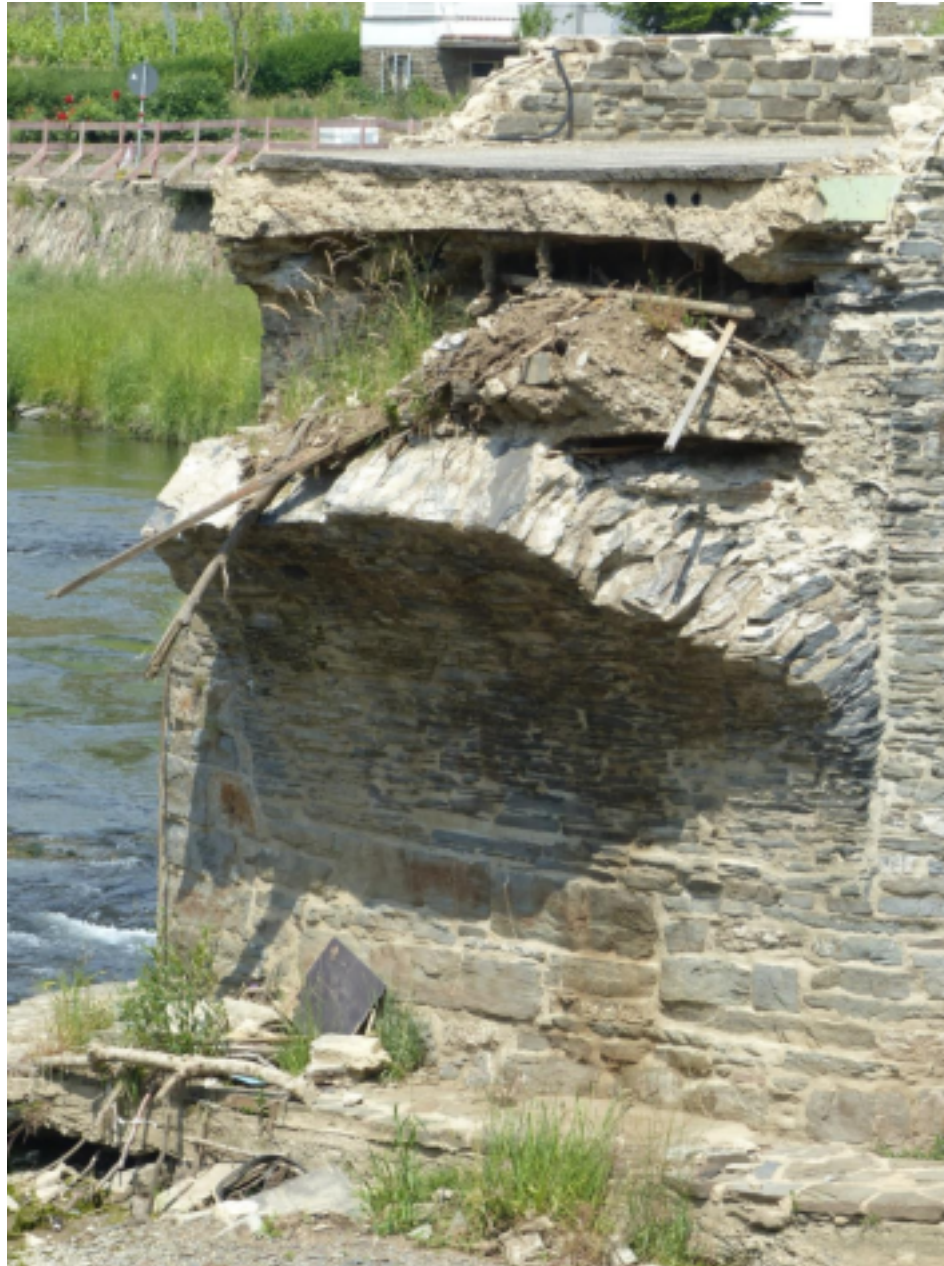
Abgebrochener Stumpf des Joches 4
