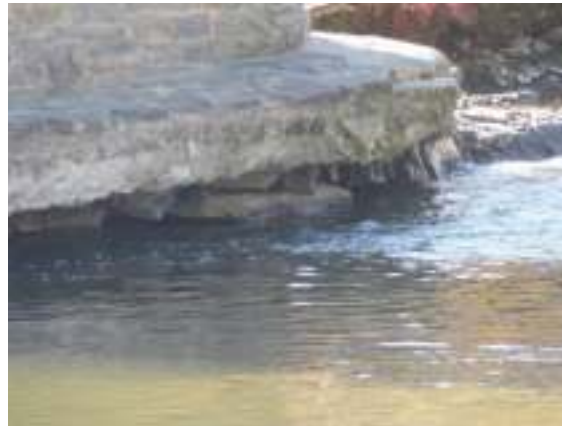
Auf einer Fels-Störungszone stehender Pfeiler 2 – Kolk an Nordseite und historische Rollierungen
