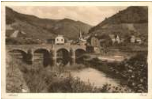
Auswahl historischer Postkarten, die eine Verlandungstendenz am rechten Ufer und zu geringen HW-Schutz des rechten Widerlagers zeigen
